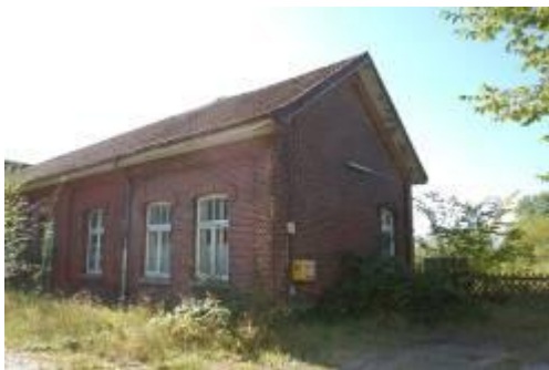
Selbst die Zufahrtstraße ist überwuchert
