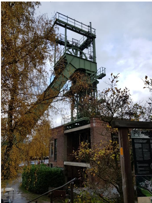
Förderturm und Betriebsgebäude
